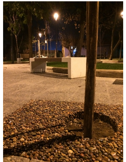
Imagen 7_Detalle de alcorque drenante, elaboración SECPLAC.
